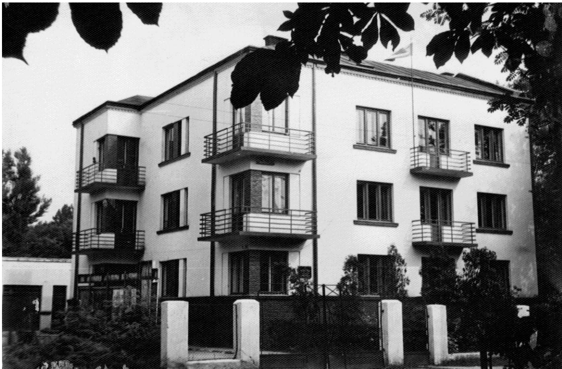
Будівля виконкому Рава-Руської міської ради. 1987 рік
